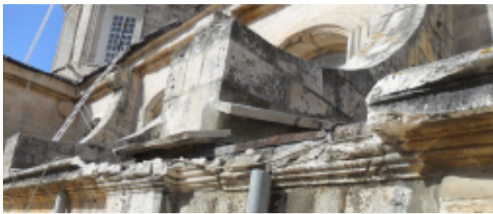
Kameni kanal prije obnove.
