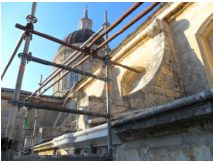
Kameni kanal nakon ugradnje.
